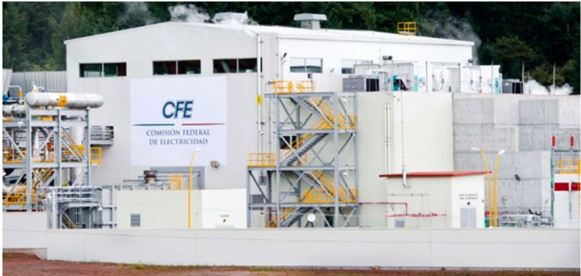
Tejamaniles, en Los Azufres, es de las pocas centrales geotérmicas que tienen condensador de tubo (titanio) y coraza, lo que simplifica mucho la obra civil para el sistema de enfriamiento.
