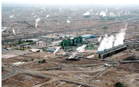
En 1972 se inauguró la primera gran central geotérmica en México: Cerro Prieto I, con 150 MW.
